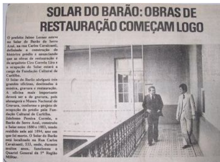
O prefeito Jaime Lerner vistoriando o espaço do Solar do Barão, em 1980
